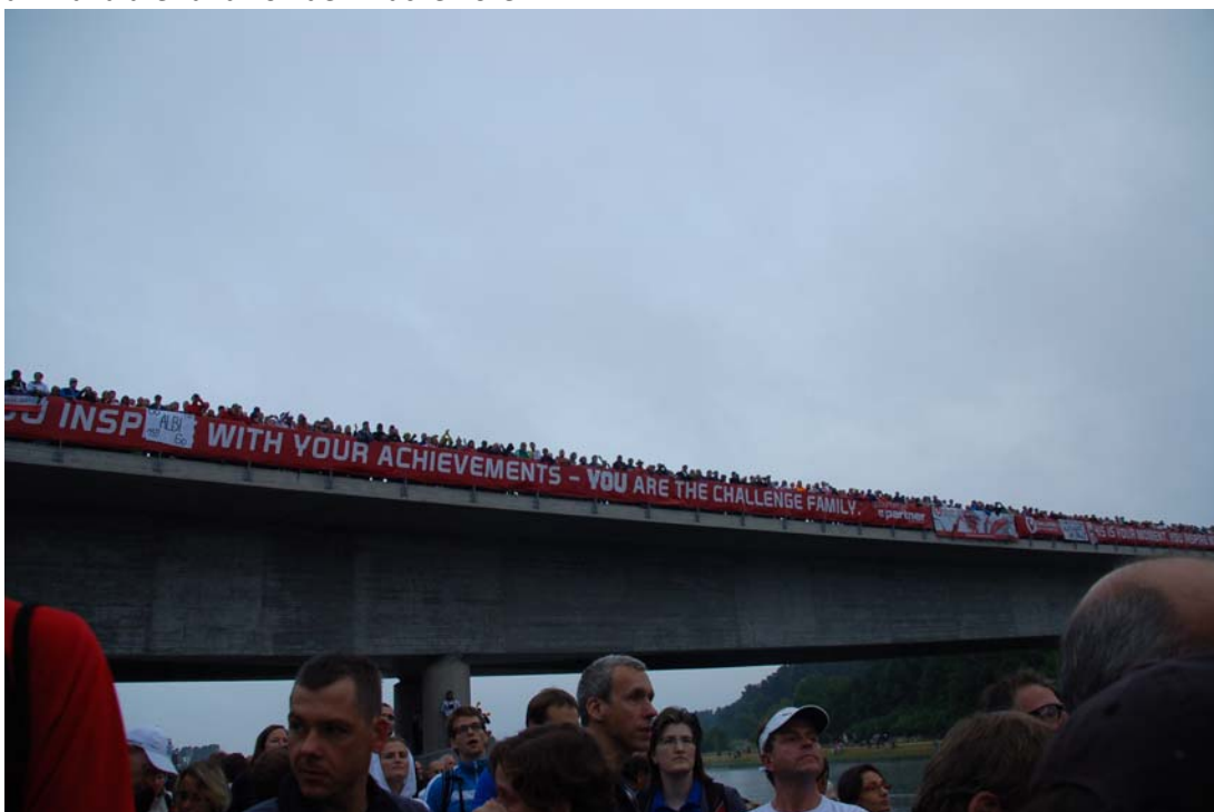
Brücke über der Schwimmstrecke
